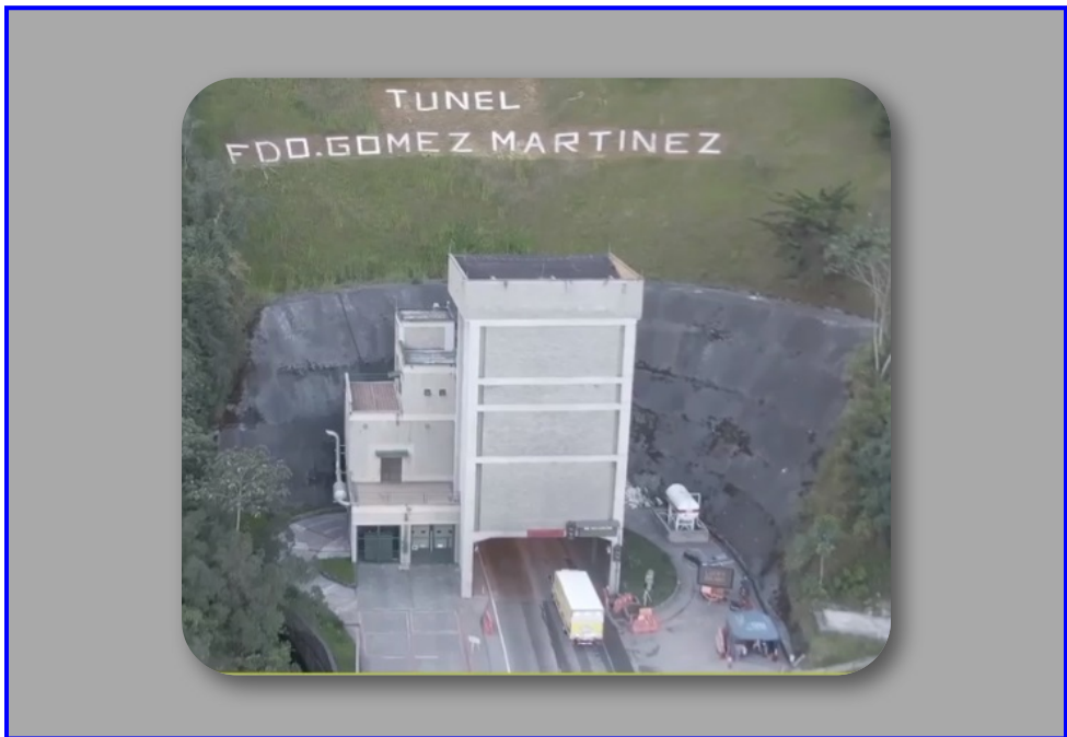
Figura 3.91. Túnel Fernando Gómez Martínez o Túnel de Occidente.
