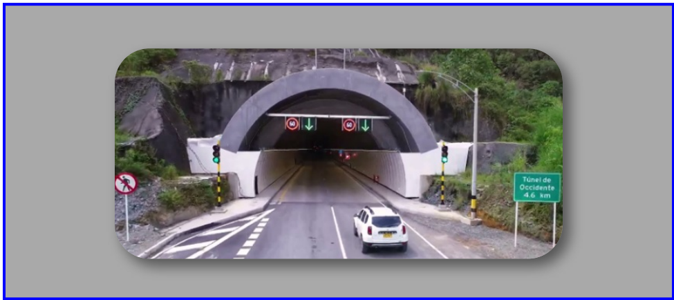
Figura 3.92. Túnel de Occidente.
