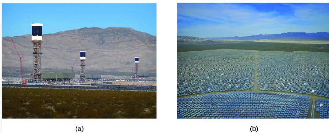
Figura 5.10. (a) La planta termosolar de Ivanpah usa 170,000 espejos para concentrar la luz solar en torres llenas de agua. (b) Cubre 4000 acres de terreno público cerca del desierto de Mojave y la frontera de California y Nevada. (Crédito a: modificación del trabajo por Craig Dietrich; crédito b: modificación del trabajo por “USFWS Pacific Southwest Region” / Flickr)
