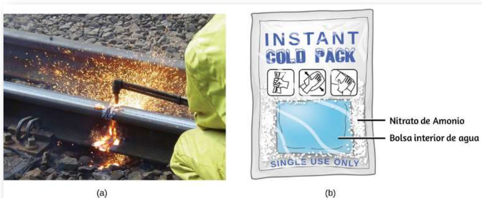
Figura 5.7. (a) Un soplete de oxiacetileno produce calor por la combustión de acetileno en oxígeno. La energía liberada por esta reacción exotérmica se calienta y luego derrite el metal que se está cortando. Las chispas son pequeños trozos de metal fundido que se alejan volando. (b) Una compresa fría utiliza un proceso endotérmico para crear la sensación de frío. (crédito a: modificación del trabajo de "Skatebiker" / Wikimedia commons)
