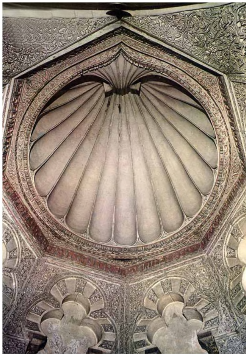
Figura 3.28. Cúpula en forma de venera (izqda.) y planta octogonal con arcos polilobulados en los laterales (dcha.) en el Mihrab de la mezquita de Córdoba.
