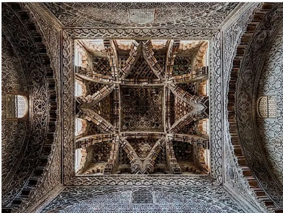
Figura 3.31. Bóveda de la capilla real realizada en madera.
