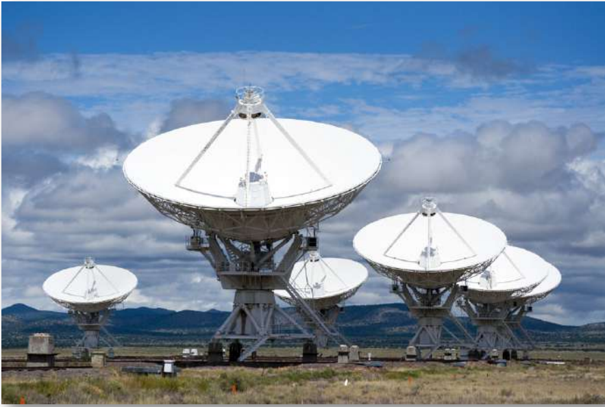
Figura 2.1. La gran matriz de Karl G. Jansky, ubicada en Socorro, Nuevo México, consiste en una gran cantidad de radiotelescopios que pueden recolectar ondas de radio y cotejarlas como si estuvieran reuniendo ondas en un área enorme sin espacios en la cobertura (crédito: modificación del trabajo de CGP Gray, Wikimedia Commons)
