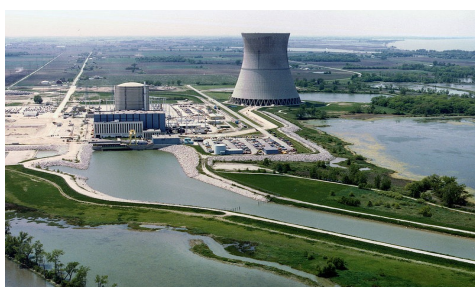
Central nuclear de Davis Besse (Ohio-USA)
