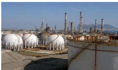
Refinería de petróleo de San Roque (Cádiz)
